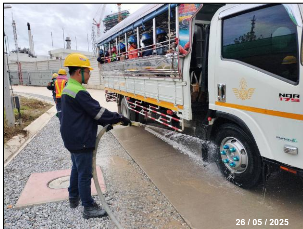
รูปที่ 2-4 การล้างล้อรถ
